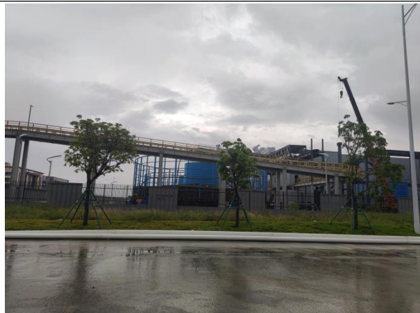
项目西面现状照片
