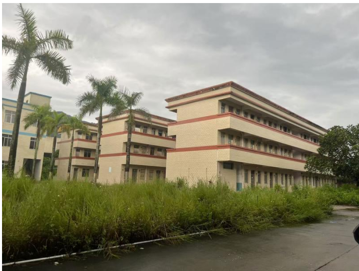
项目西南——宿舍楼
