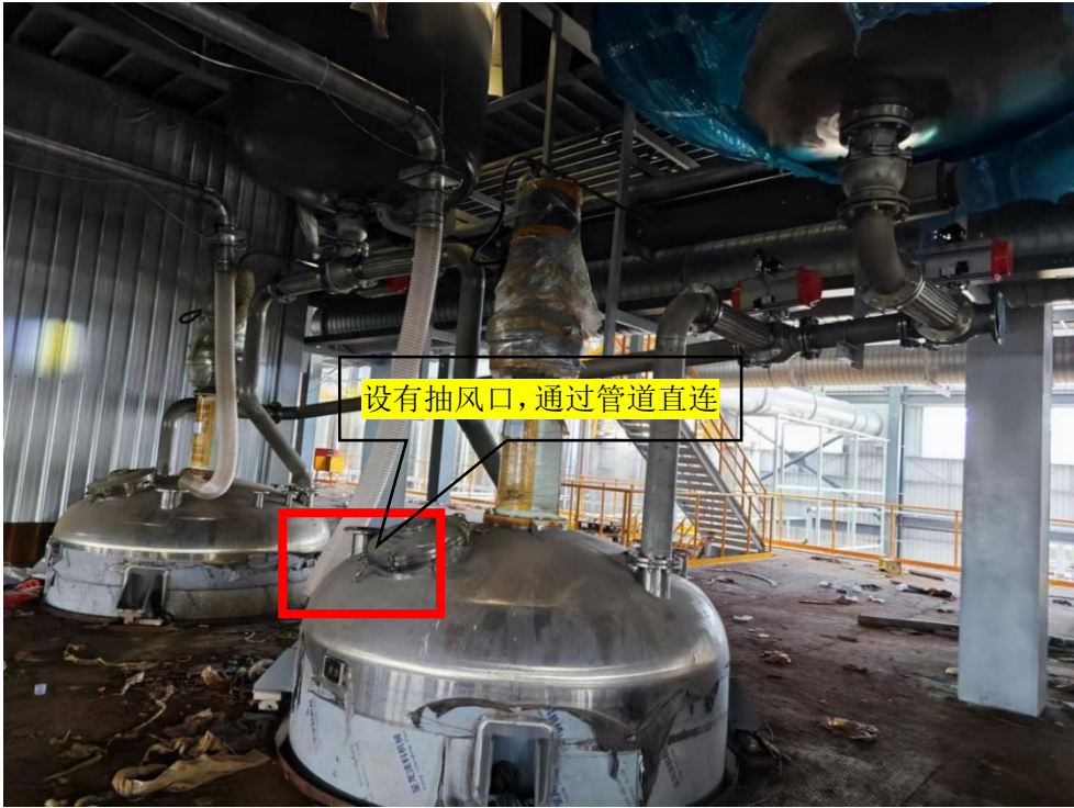
图 4-1 项目生态涂料车间废气收集示意图
