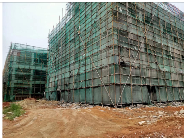
西北面-在建厂房
