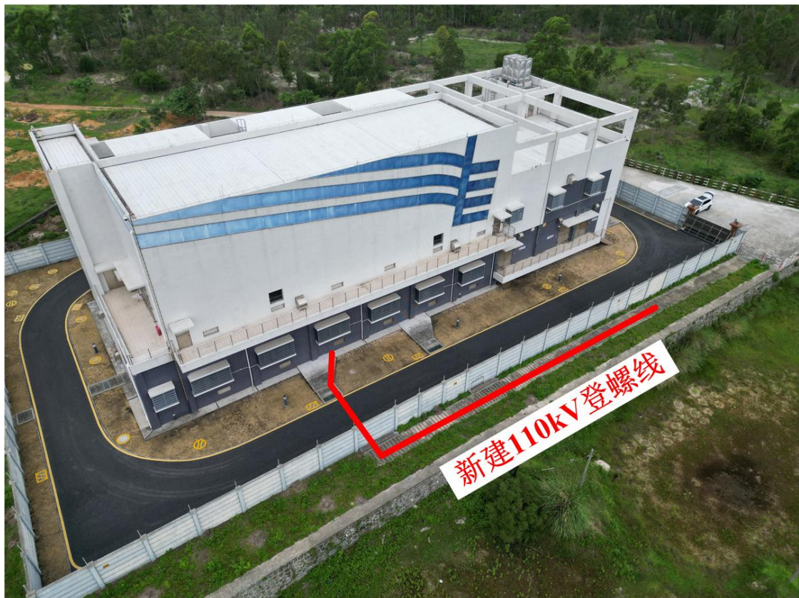
图 2-3 本工程电缆路径环境现状
