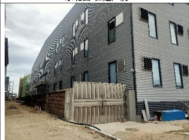
东南面-在建厂房
