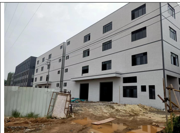
东北面-在建厂房
