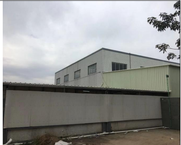
项目西面其他厂房
